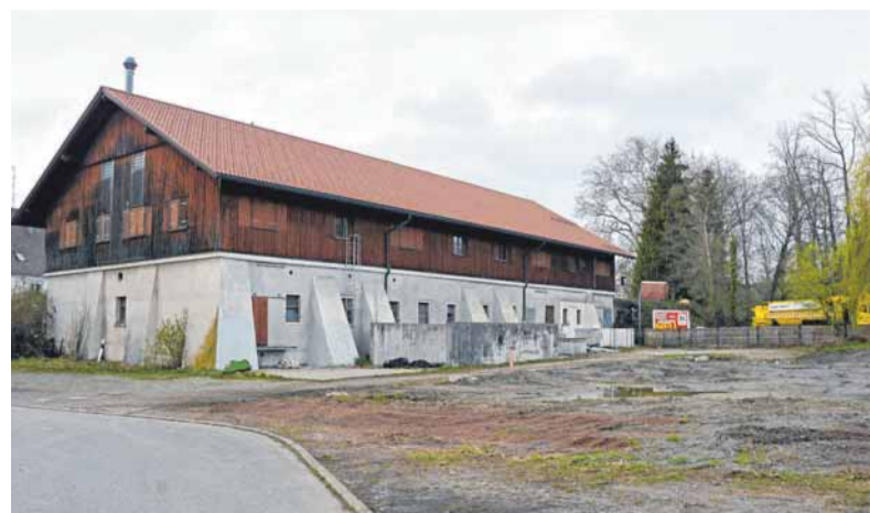
Auch das Areal auf der Rückseite des Reitstalls, wo bis vor Kurzem noch die Reithalle stand, soll mit Wohnungen bebaut werden.
